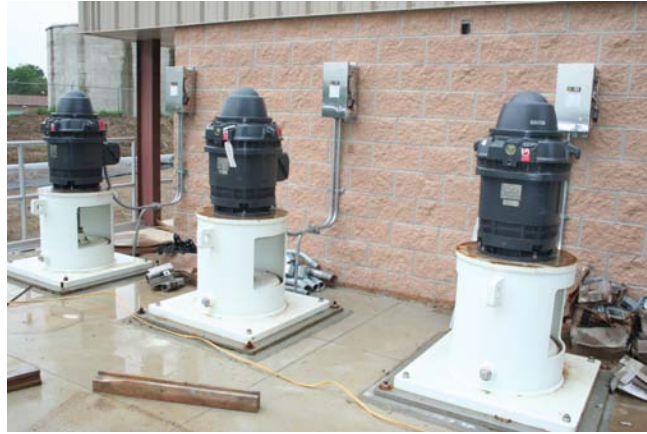
Effluent Pumps
